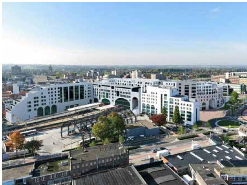
Maankwartier Station, Heerlen, Pays-Bas Architecte : J. Bak, concept : Michel Huisman
