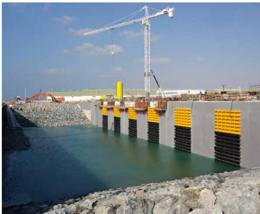
Prise d'eau de mer, station de pompage et canal de décharge de Hamriyah, Dubaï, EAU
