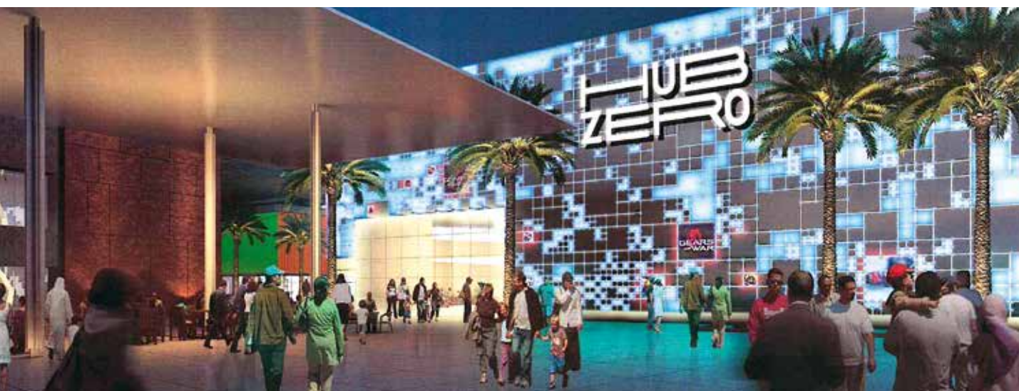
Bâtiment Hub Zero, Jumeirah, Dubaï, EAU
