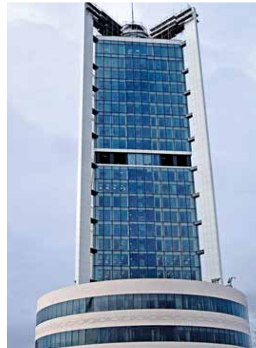
Tour Sofaz, Bakou, Azerbaïdjan, Architecte : MDM Group
