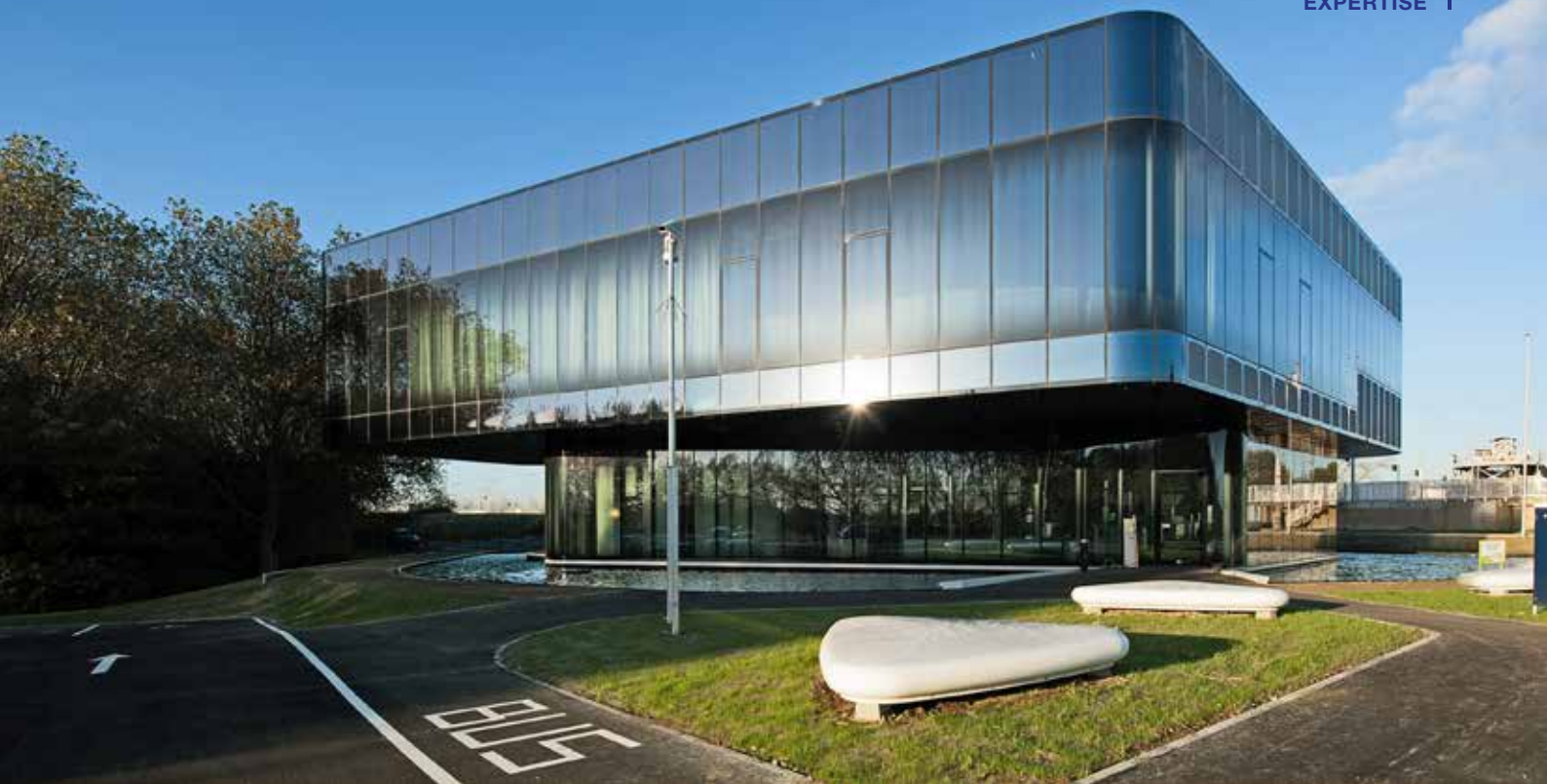
Regiocentrale-Zuid, Maasbracht, Pays-Bas, Architecte : Wiel Arets
